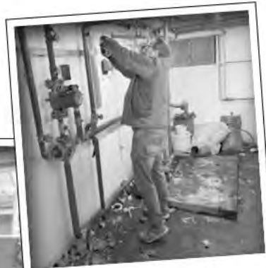
Alte Wasserleitungen entfernen
