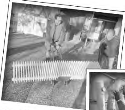
Abriss der alten Ölheizung
